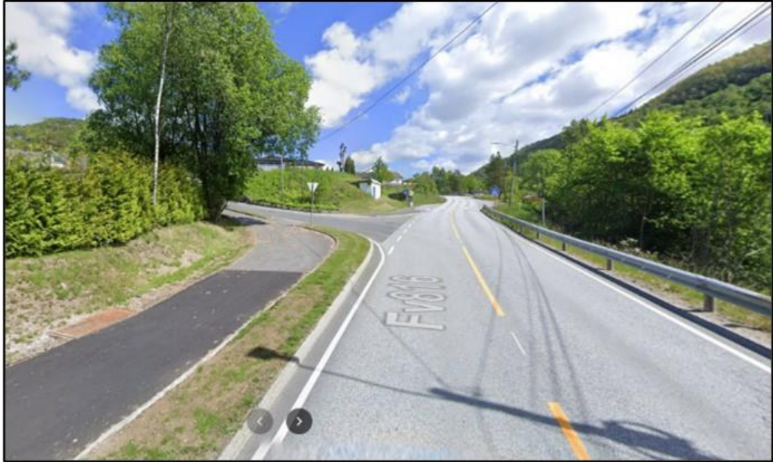
Vegkryss FV 4166 Kvinesdal kommune
