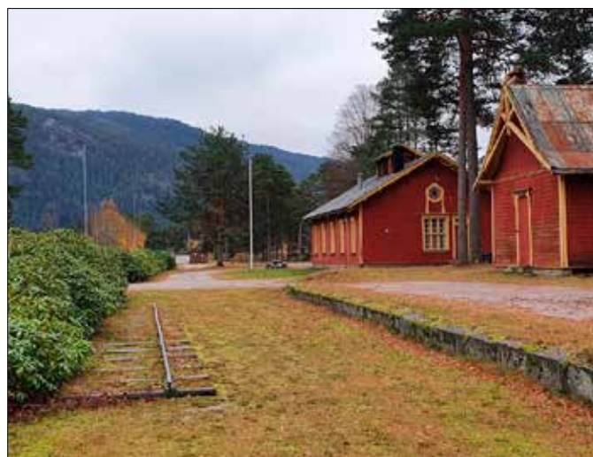
Eksempel fra Bygland stasjon med jernbanespor og gruset perrong. Foto: Agder fylkeskommune
