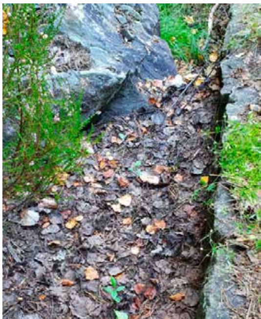
Steinsatt grøft Foto: Agder Fylkeskommune
