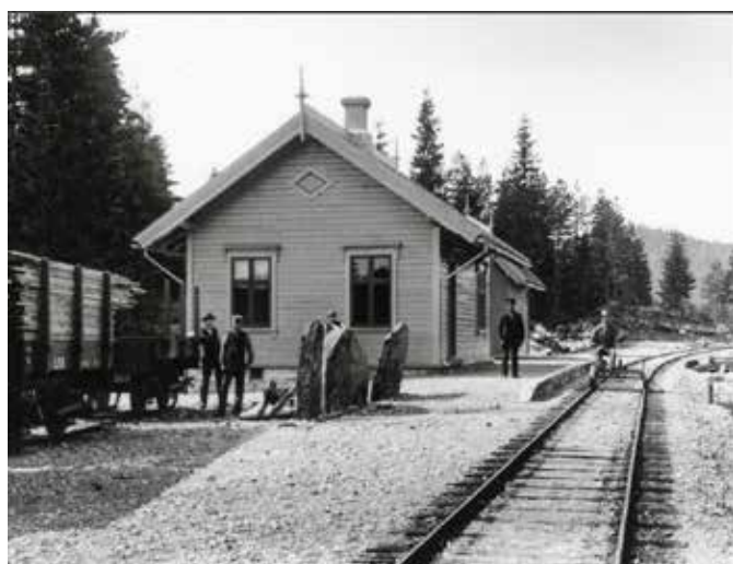
Tveide stasjon. Foto: Statsarkivet i Bergen
