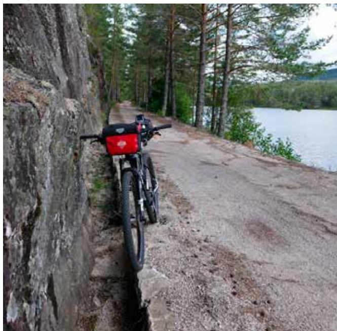
Eksempel på fremgravd steinkant, Treungenbanen Foto: Statens vegvesen
