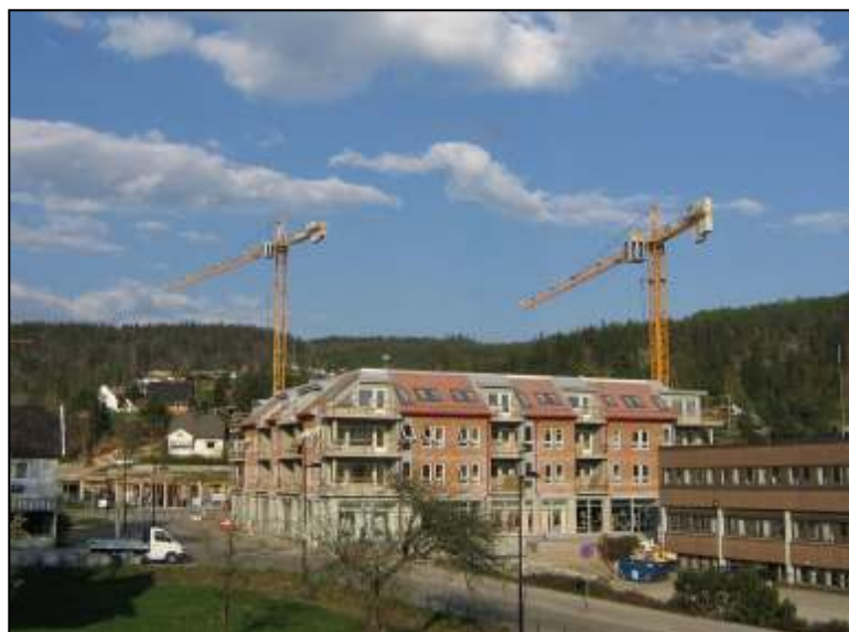
Regionen er i stor vekst og det foregår store byggeprosjekter flere steder. Bildet her er fra Vennesla sentrum.
