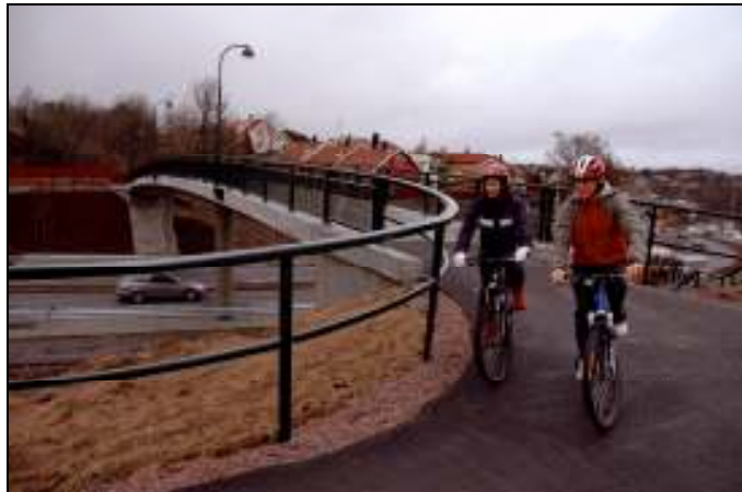
Gående og syklende har fått vesentlig forebedrede forhold med ny bro over Lumberkrysset.
