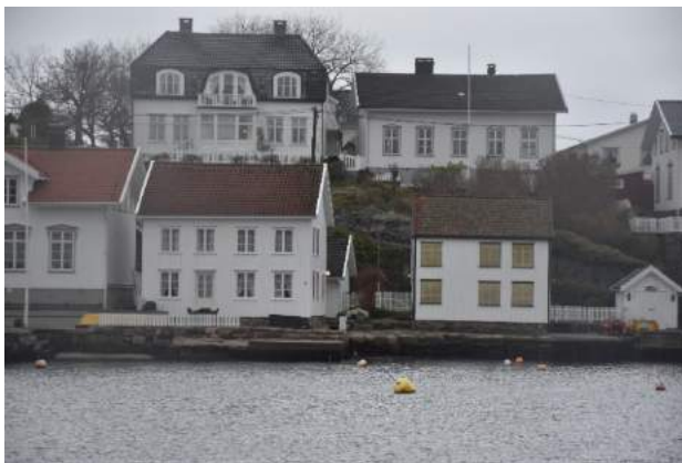
Holmen med tett bebyggelse. Til høyre et av de eldste husa i Lyngør fra 1700-tallet er holdt forbilledlig stand og lesbarhet. Bebyggelsen for øvrig er fra 1800-tallet, med unntak av det store nyklassistiske huset bak til venstre, som er fra begynnelsen av 1900-tallet.
