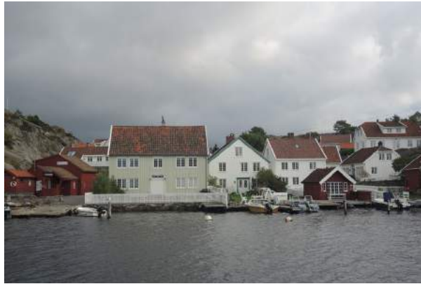
Bebyggelsen ligger godt innpasset i en naturlig kløft mellom bratte bergknauser. Stedet har generelt store kvaliteter i bebyggelsesstruktur med gammel bebyggelse og rester av historiske hager.
