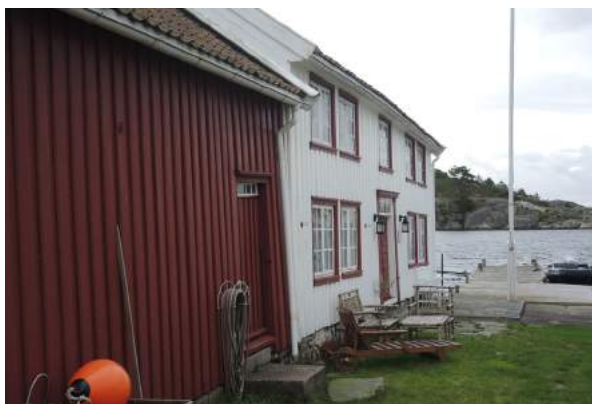
Dette 1700-tallsanlegget i Brekkstø skiller seg ut med koblingen mellom hovedhus og uthus. Autentisk og fin bebyggelse.
