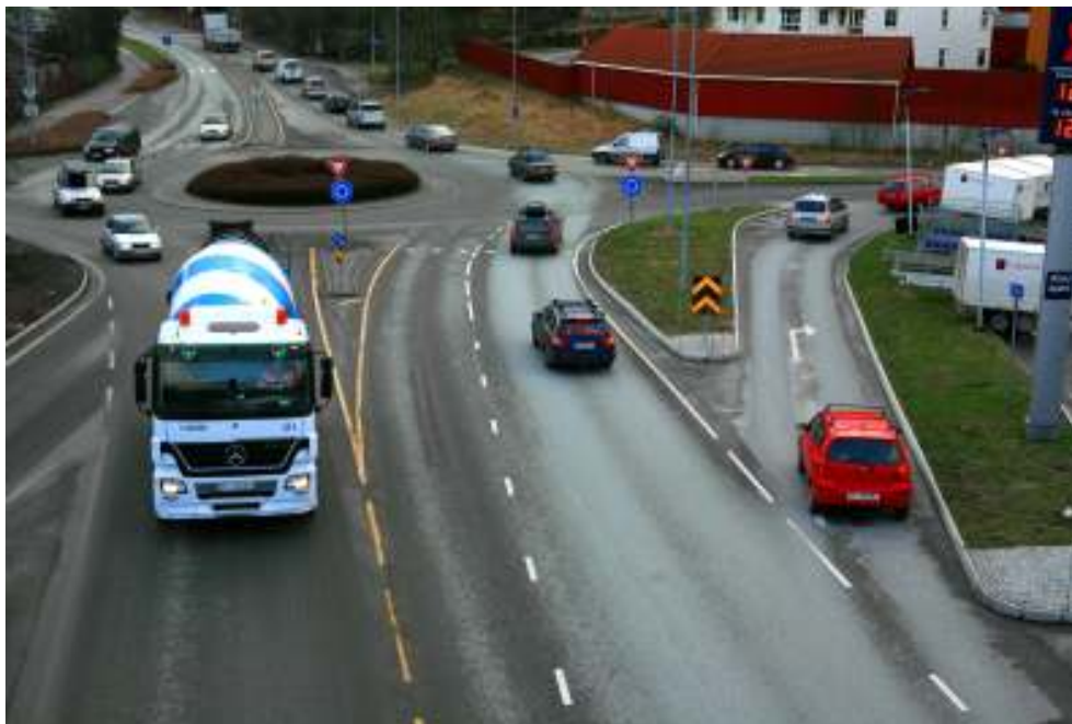
Filterfeltet i Fiskaa-krysset i Vågsbygd var en genistrek (til høyre på bildet). Det har bidratt til at køen i ettermiddags-rushet på Vågsbygdveien er redusert. Filterfeltet ble bygd for ATP-midler i 2007.
