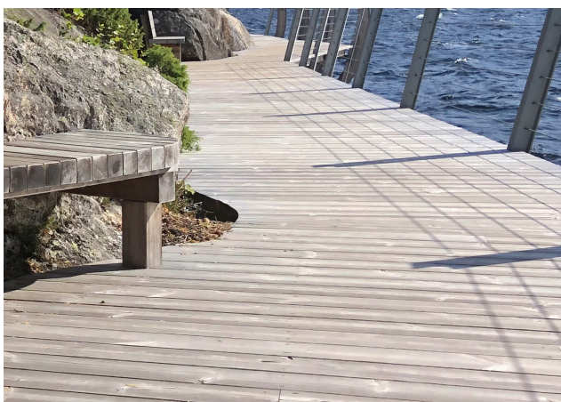
Bildet over: Tredekke som et naturlig materialvalg langs vann og sjø som ved Hamaran Aktivitetspark i Fyresdal. Foto:Tine Eilen Gunnes
