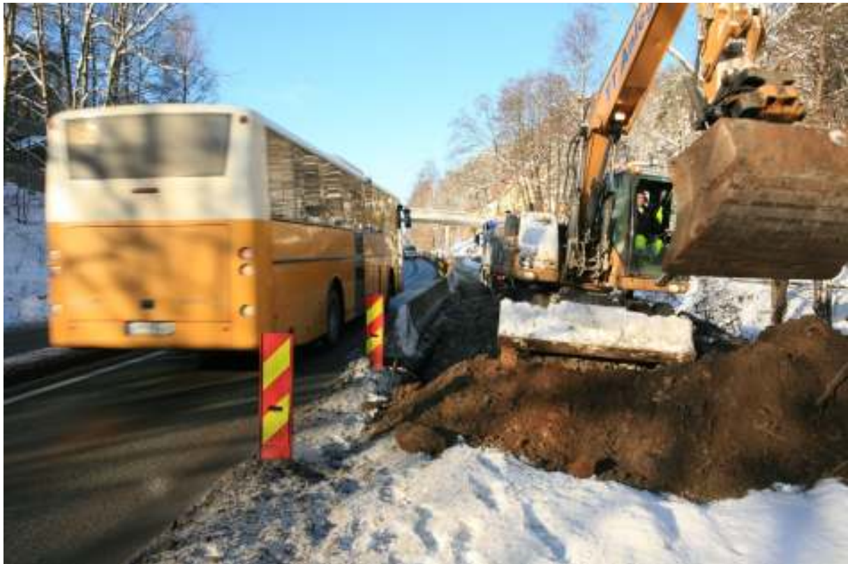
Kollektivfelt ved Kartheikrysset på E39 ble ferdig planlagt og kontrakt inngått med entreprenør høsten 2008. Like over nyttår i 2009 startet arbeidene. Foto: Bjørne Jortveit)
