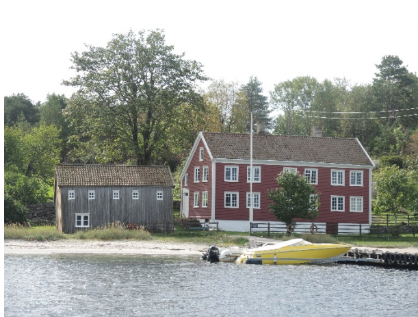
Fredet anlegg på Merdø gård
